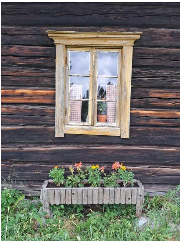
Kukkaistutukset ja uudet verhot keskirakennuksen ikkunassa.
