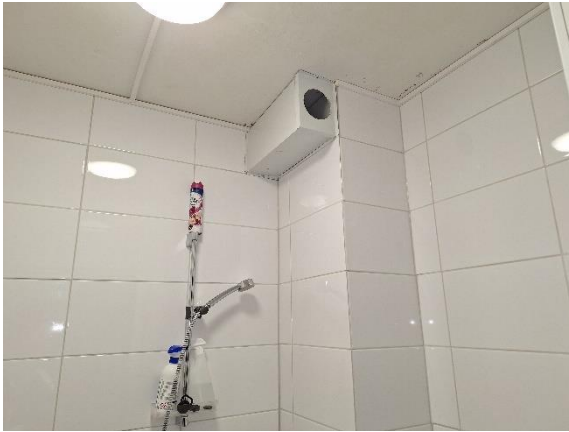
Kuva 6 Lasten wc-tilassa oleva poistoilmahormi on peltikanavan takana.
