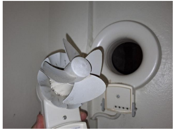
Kuva 9 Tuuletin oli puhdistettu.
