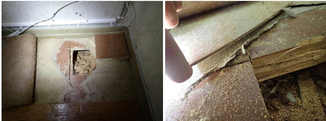
Kuva 11. Välipohjarakenteeseen tehtiin rakenneavaus rakennekerrosten varmistamiseksi. Vanhan lankkulattian päälle on asennettu pahvi, kovalevy ja muovimatto.
