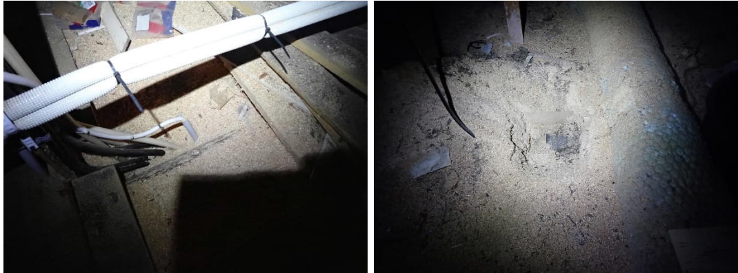
Kuva 35. Yläpohjarakenne tarkastettiin ullakon kautta. Purueristeen alla on tervapaperi ja aluslaudoitus, jonka alla ovat alakattorakenteet.
