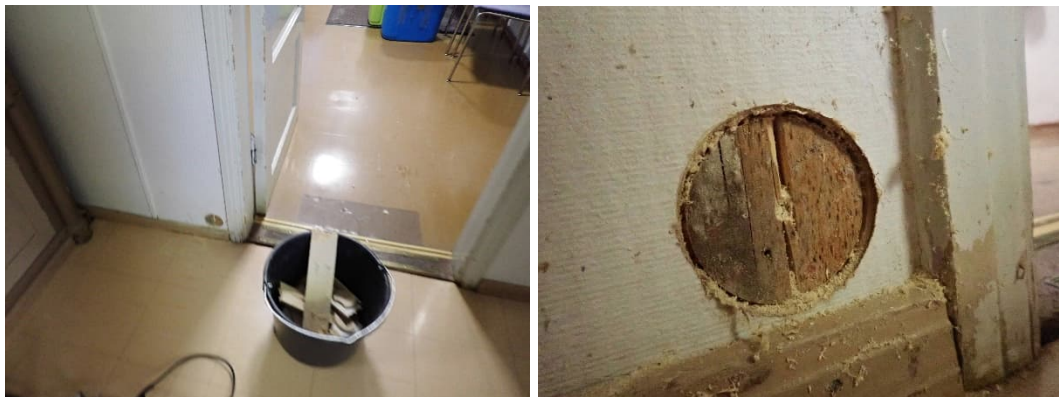
Kuva 17. Hirsiset väliseinät on pinnoitettu pinkopahvilla.
