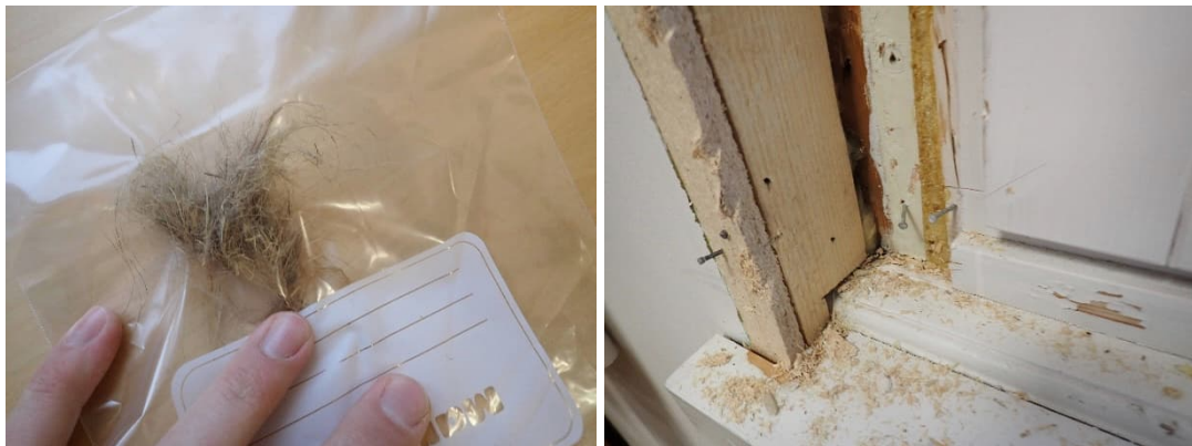
Kuva 30. Vanhojen ikkunakarmien tilkkeenä on käytetty rivettä. Uudemmat karmit on eristetty uretaanivaahdolla vanhaan karmiin.
