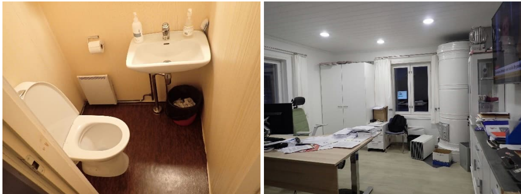
Kuva 9. Wc-tiloissa on vanha muovimatto. Remontoiduissa tiloissa on hyväkuntoinen viinyylilankku.
