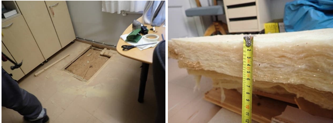
Kuva 1. Alapohjarakenteeseen tehtiin laajempi rakenneavaus, josta nähtiin rakennekerrokset. Rakennetta on lisäeristetty ilmeisesti kahteen eri otteeseen. Nykyiset pintamateriaalit ja mineraalivillaaeristys on ilmeisesti lisätty 1987 tehdyssä korjauksessa. Purueristeen välissä oli sanomalehtiä jotka oli päivätty vuodelle 1948, tämä viittaisi mahdollisesti silloin tehtyyn lisäeristykseen.
