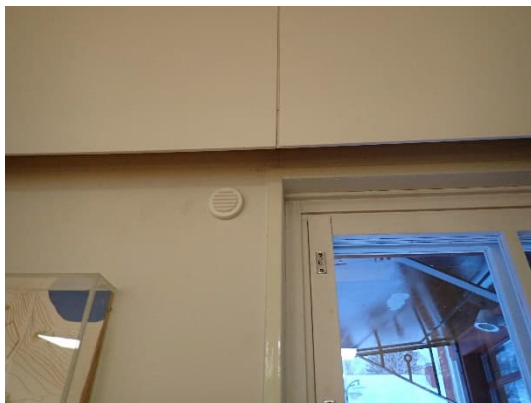
Kuva 41. Eri puolille rakennusta ulkoseiniin on asennettu korvausilmaventtiileitä. Venttiileistä todettiin tulevan korvausilmaa sisäilmaan.
