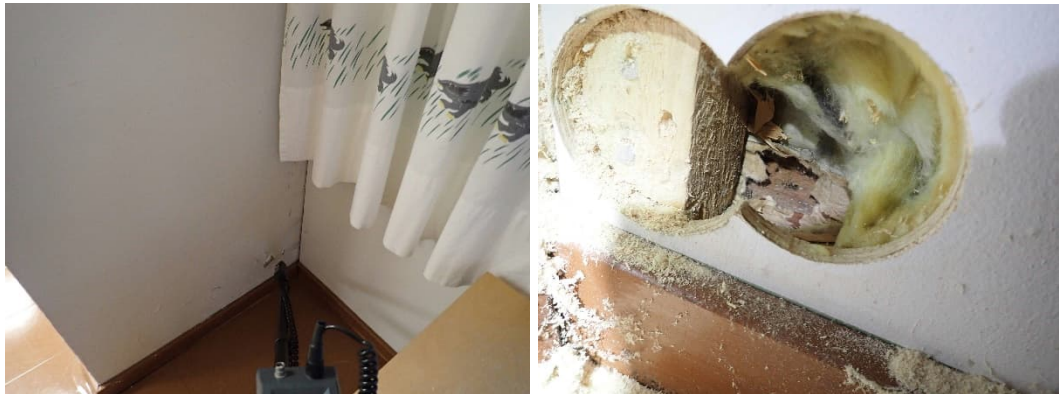
Kuva 16. Valtuustosalin ulkoseinät on koolattu ja lisäeristetty 50 mm mineraalivillalla.
