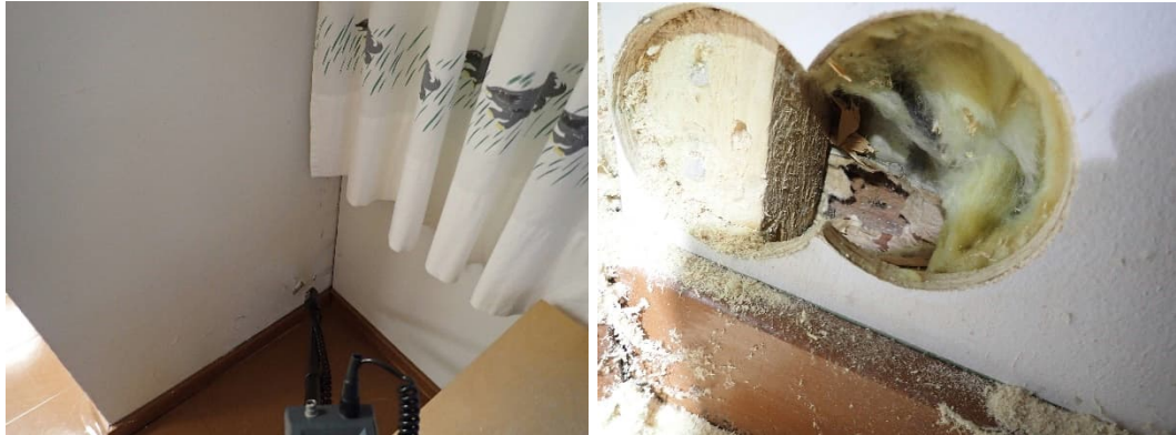
Kuva 12. Valtuustosalin seinät on lisäeristetty 50 mm mineraalivillalla.
