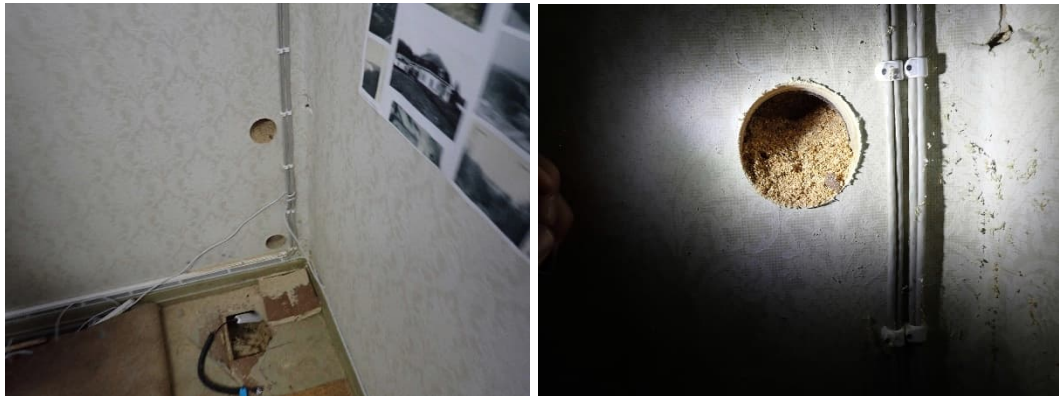
Kuva 15. Toisen kerroksen taukotilan ulkoseinään tehdyn rakenneavauksen perusteella hirsirunko ulottuu noin 400 mm lattiapinnan yläpuolelle, josta rankarunko alkaa.
