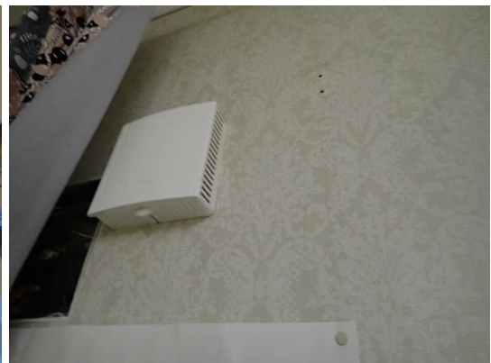
Kuva 41. Eri puolille rakennusta ulkoseiniin on asennettu korvausilmaventtiileitä. Venttiileistä todettiin tulevan korvausilmaa sisäilmaan.
