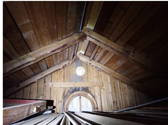
Kuva 32. Yleisnäkymä ullakotilaan. Päätykolmioissa on tuuletusventtiilit.
