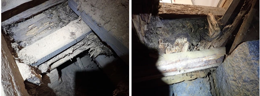
Kuva 3. Alapohjarakenteeseen tehtiin laajempi rakenneavaus AP1, josta nähtiin rakennerokot ja päästiin tarkastamaan ryömintätila.
